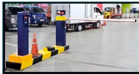
하역장 진입 불가하도록 차단기 설치
